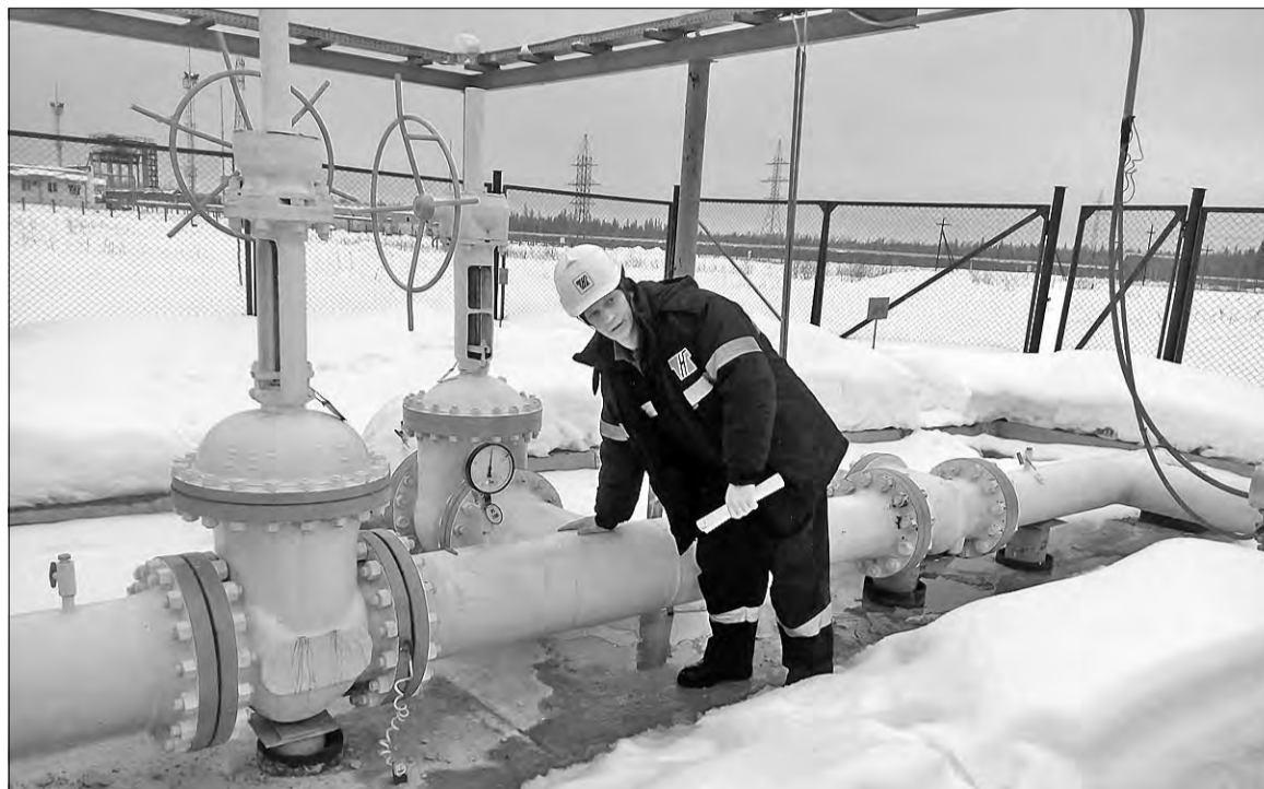
■ Заместитель начальника цеха подготовки и перекачки нефти № 6 «Томскнефть» ВНК Анатолий Альберти: «Благодаря мультифазной насосной станции мы можем перекачивать неподготовленную скважинную жидкость»
