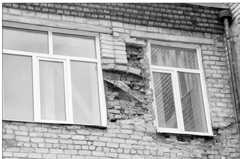
■ Из-за проблем с кровлей здание школы в селе Чилино разрушается на глазах
