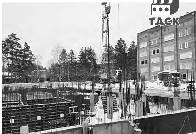
■ Строительство хирургического корпуса онкодиспансера
