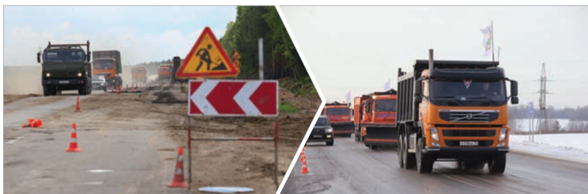
■ Трасса в процессе ремонта и после его завершения
