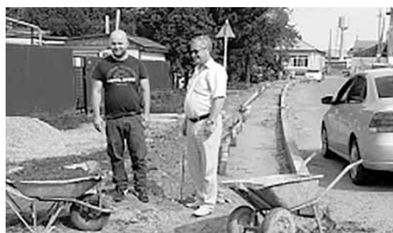
■ И.о. главы поселения Иван Герцен (справа) лично контролирует ход благоустроительных работ
