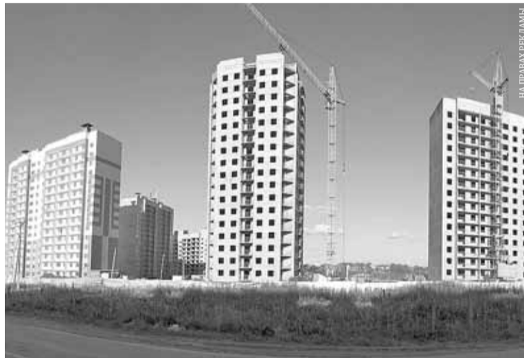
■ 2015 год. Начало строительства Южных Ворот
