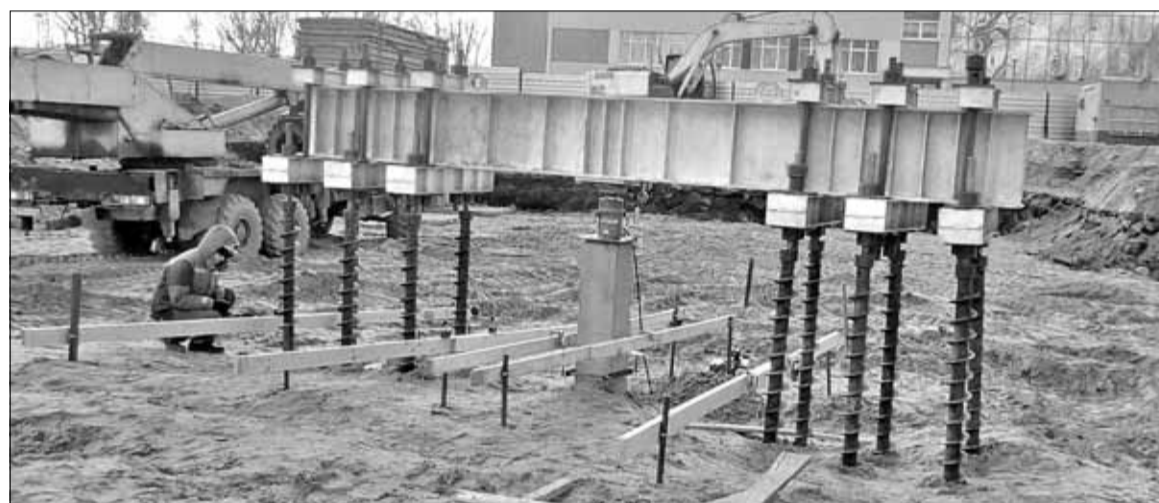
■ Установка для испытания свай
