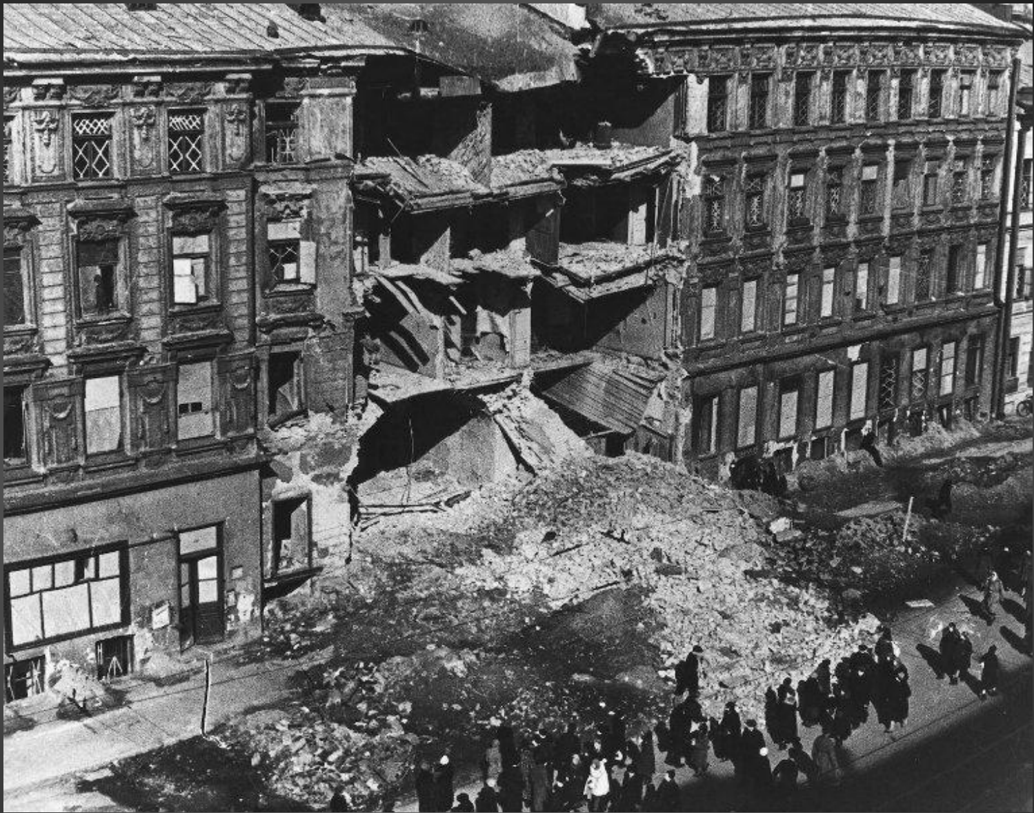
Это фотография дома, разрушенного авиационной бомбой.
